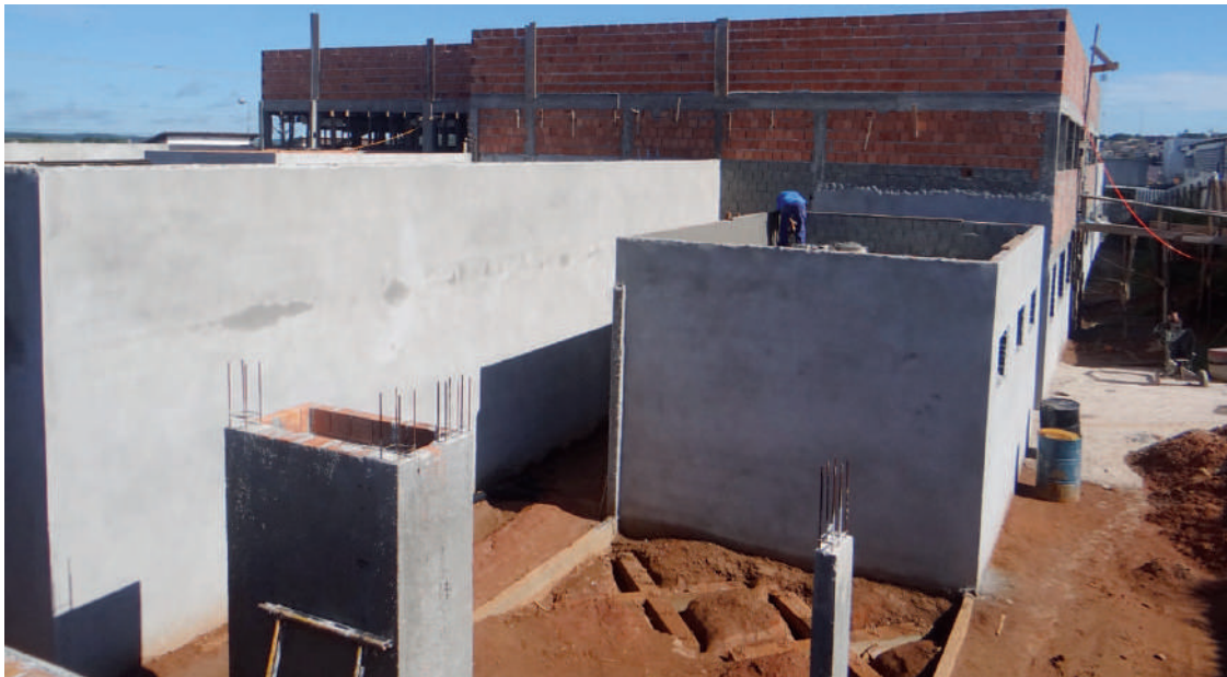
Futuras instalações da Unidade de Pronto Atendimento
